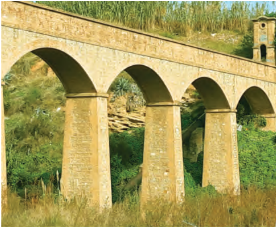
Figura 15. Aqüeducte de Can Nyac, situat a la vora de l'estació de metro de Gavarrà (barri de Sanfeliu). Darrere de la segona arcada es poden observar roques de color groc que afloren al barranc i que corresponen a sediments del Pliocè. Fotografia: Eric Baulenas
